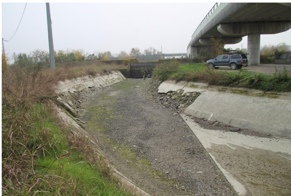
Figura 5. Rivestimento delle sponde in cls ammalorato.
