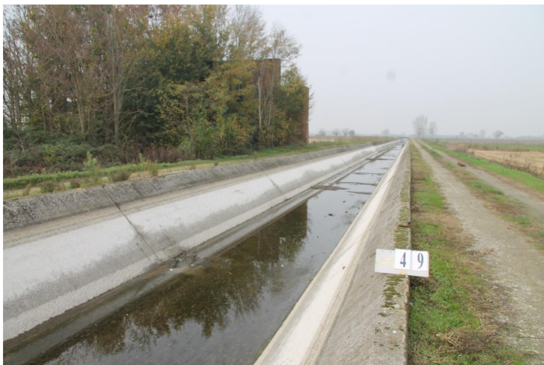
Figura 7. Rivestimento delle sponde in lastre di cls.
