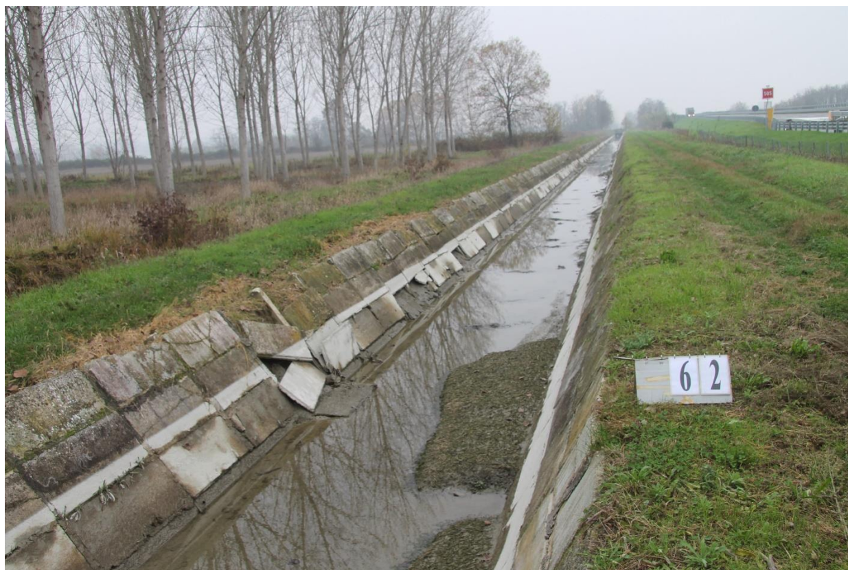
Figura 8. Rivestimento delle sponde ammalorato in lastre di cls.
