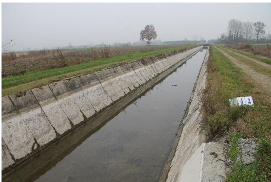
Figura 6. Rivestimento delle sponde in lastre di cls.
