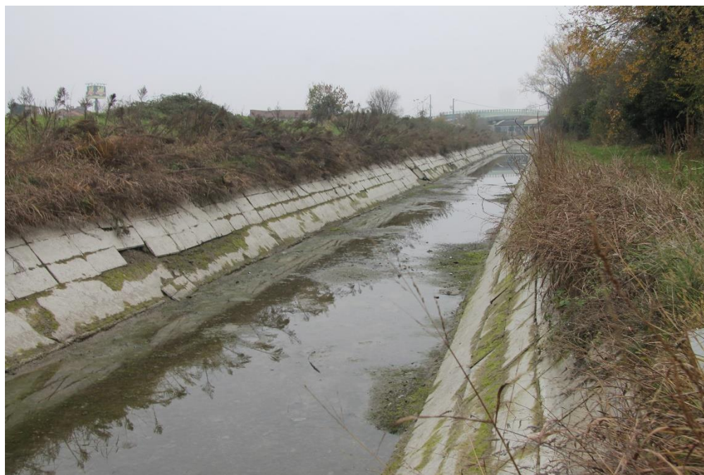
Figura 4. Rivestimento delle sponde in lastre di cls.
