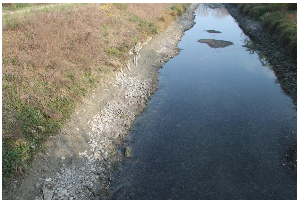
Figura 2. Sponde in terra e ciottoli nel tratto di monte del canale.
