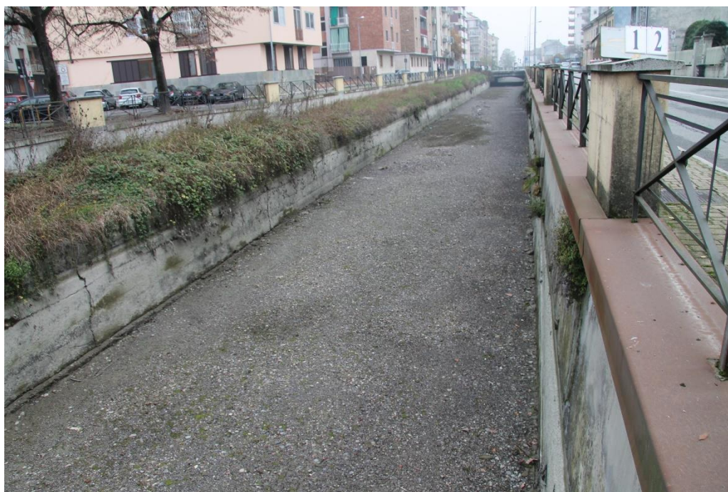
Figura 3. Tratto urbano del canale Lanza a Casale Monferrato, con muri di sponda in cls.
